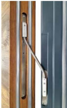
Steckbarer Kabelübergang für EAV4 & EAV4+
